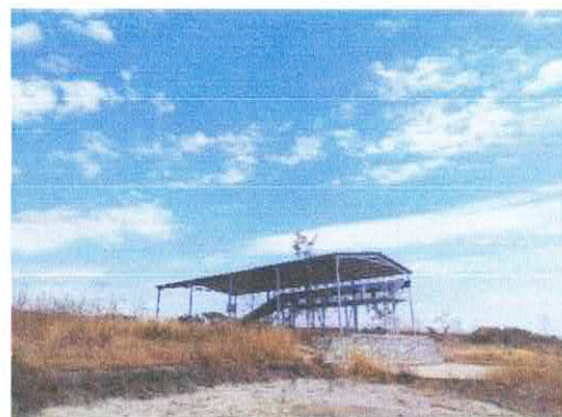
Banda separación Relleno Intermunicipal Yahualica
