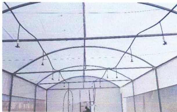
Instalación de riego automatizado
