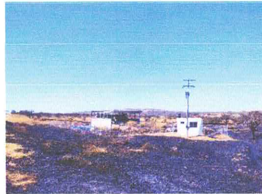
Panorama general de Planta transferencia después de quema controlada
