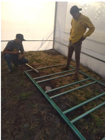
Figura 31. Actividades de vivero-Mantenimiento de instalaciones.
